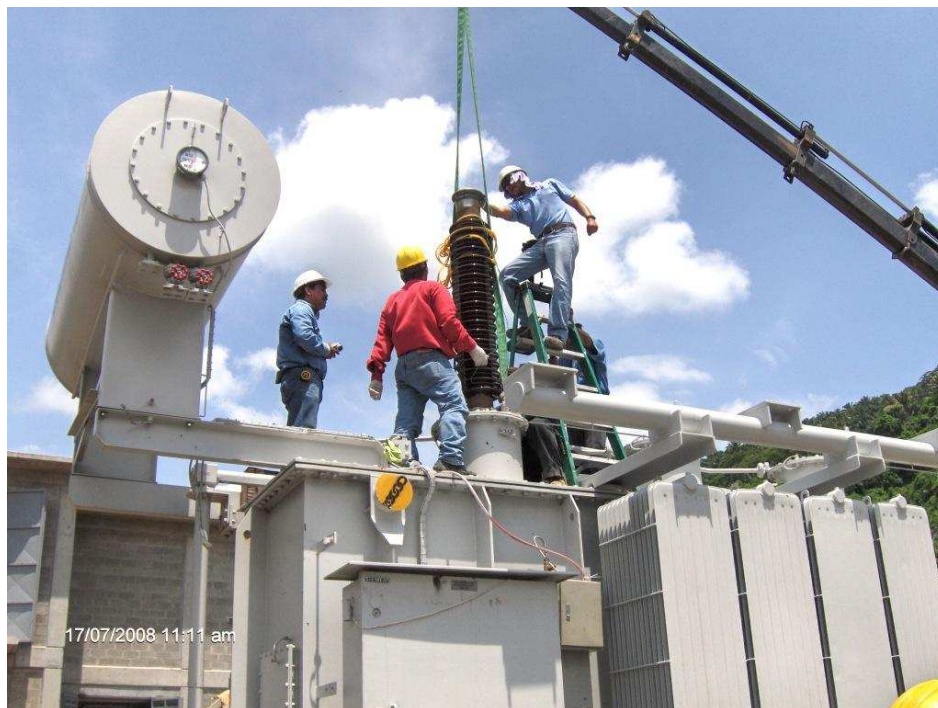
Montaje de Transformador de Potencia, SE CENOSA BIJAO 138 KV.
