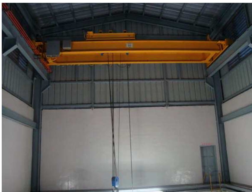
Montaje de Grúa Viajera.
